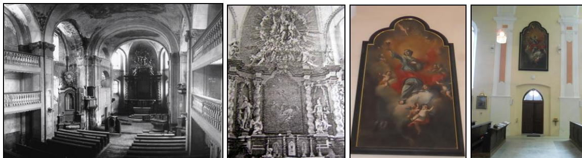
Zleva: interiér odstřeleného kostela ve Valkeřicích (snímek z roku 1975 před odstřelem – oltářní obraz zde již není). Snímek oltáře s obrazem kolem roku 1930. obraz sv. Barbory a celkové umístění nad vchodem v kostele.
