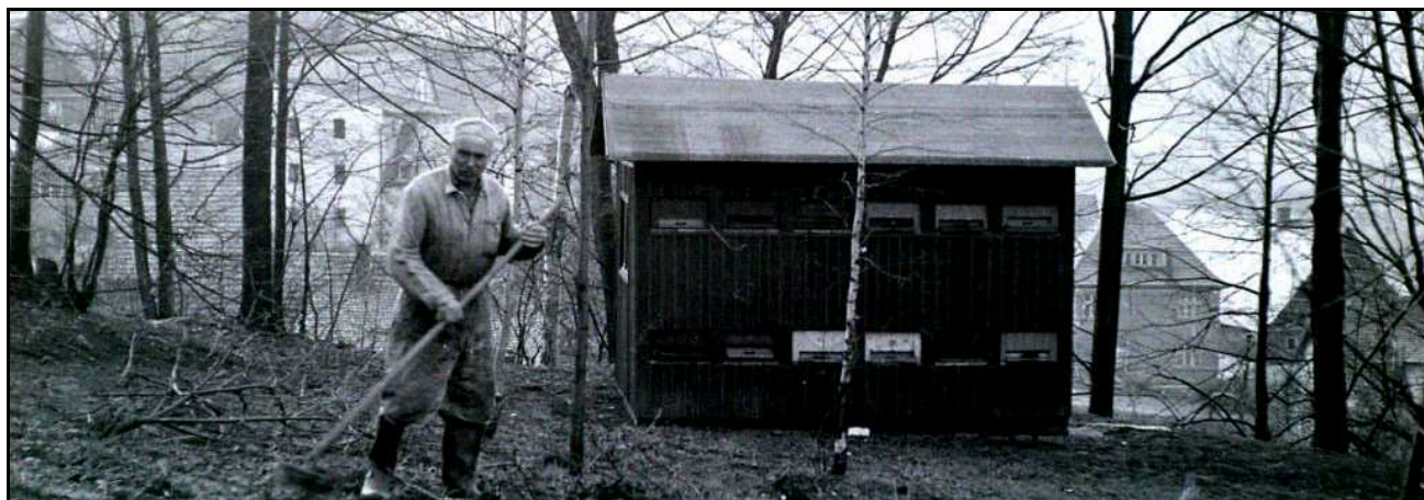
Na snímku z roku 1960 je včelín postavený v lese v M. Veleni za číslem 34. V pozadí vlevo je budova starého mlýna (zbouráno), vpravo pak dům č. 29 a dnes již zbourané stavení č. 30.
