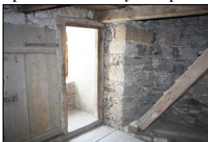
V 1. poschodí věže bývala místnost pro ponocného, do které se vcházelo po venkovním schodišti dveřmi, po kterých zůstal částečně zazděný dveřní otvor, který dnes slouží jako okno – snímek vlevo.
