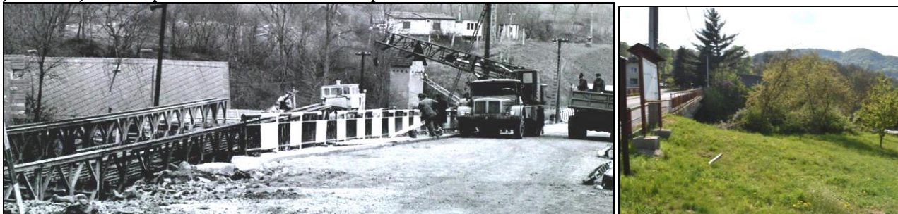
Na snímku vlevo je provizorní montovaný most pro auta v době, kdy se mosty stavěly. Vpravo je současný snímek místa, kde byl náhradní most položený.
